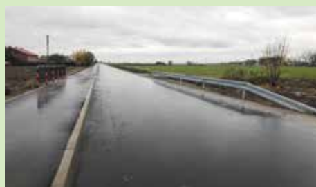
Przebudowa drogi w miejscowości Janów
