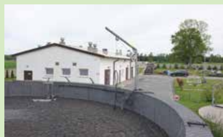
Oczyszczalnia ścieków w Grodźcu
