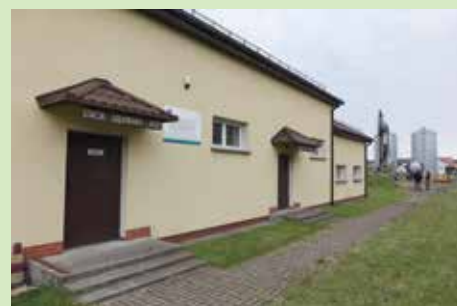
Stacja Uzdatniania Wody w Grodźcu
